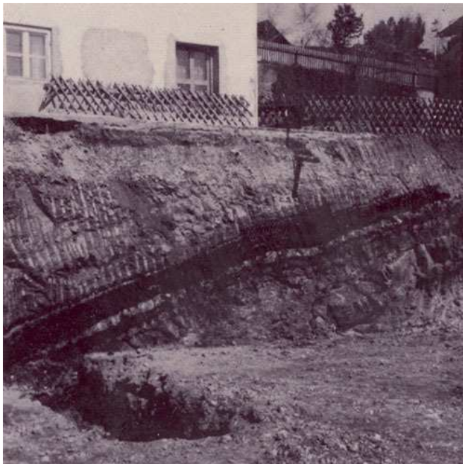
Abb. 6: Kohleflöz in Miesbach, aufgenommen im Juni 1975 in der Baugrube Höhe des Anwesens Hofäcker am Tölzer Berg und der Schlierach.
